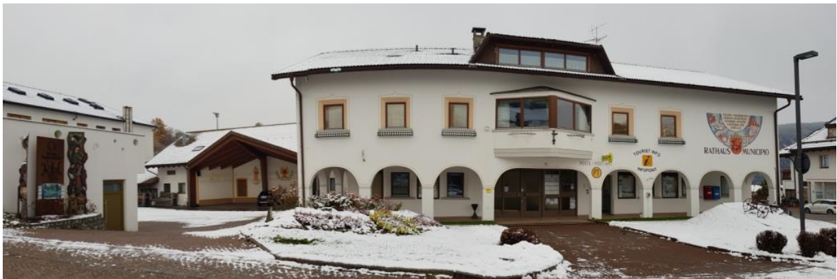
Blickrichtung 3: Ansicht Nord mit Haupteingang, links Zugang Festplatz
