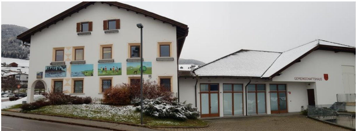
Blickrichtung 1: Fassade Westansicht
