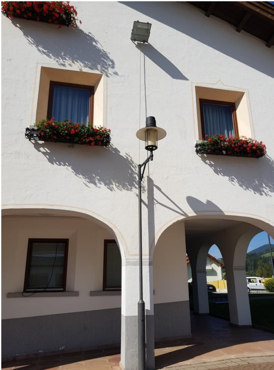
Ostseite, Beleuchtung an der Außenfassade Lato est, illuminazione sulla facciata
